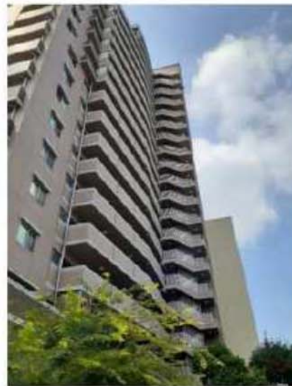
■釜川側からの臨む建物外観
